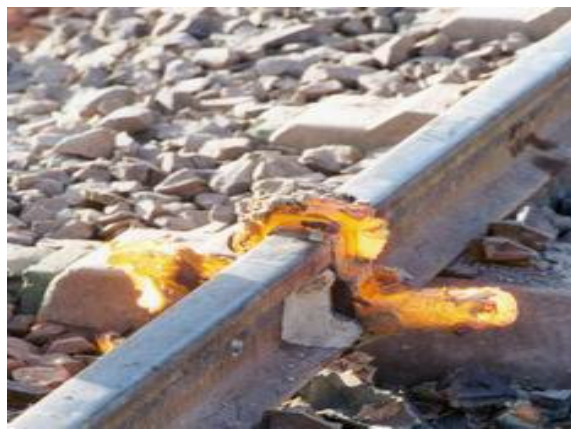
تعمیر ریل بوسیله جوشکاری ترمیت
