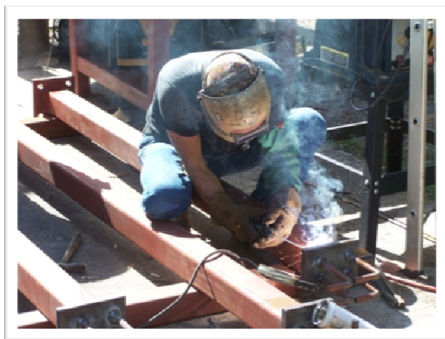
جوشکاری برق با الکتروود دستی (جوش ورق به ستون فلزی)
