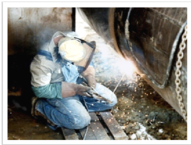
جوشکاری برق دور لوله با الکتروود دستی
