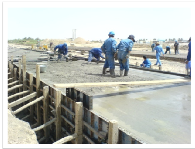
قالب‌بندی، بتن‌ریزی کف و تسطیح بتن
