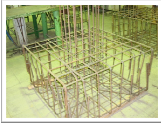
آرماتوربندی فونداسیون منفرد
