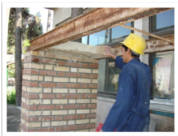
اجرای طاق ضربی در کارگاه
