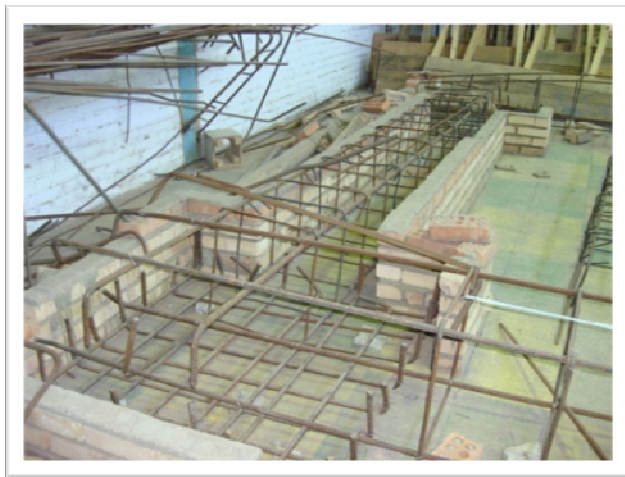
قالب‌بندی فونداسیون و شناژ با آجر
