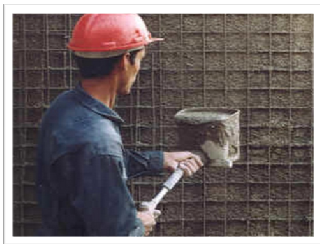
کار با دستگاه بتن‌پاش جهت بتن‌ریزی دیوار
