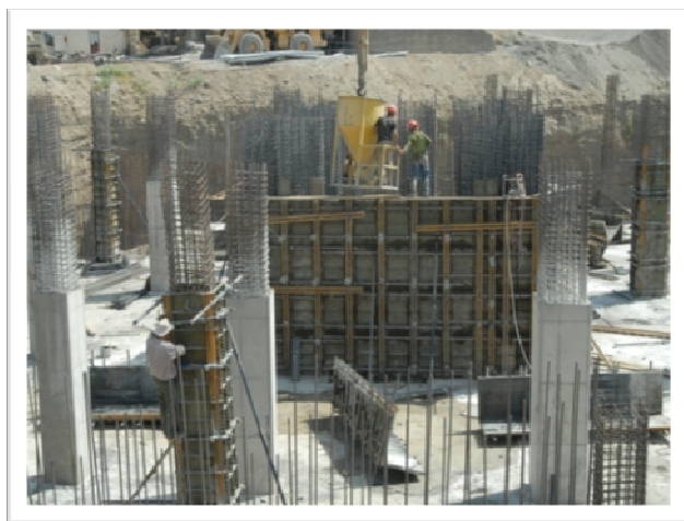
بتن‌ریزی ستونها و دیواربرشی ساختمان
