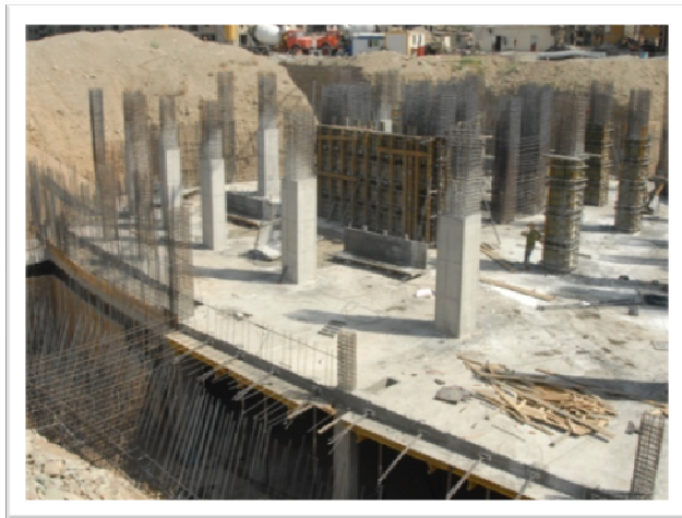
آرماتوربندی سقف و ستون جهت بتن ریزی
